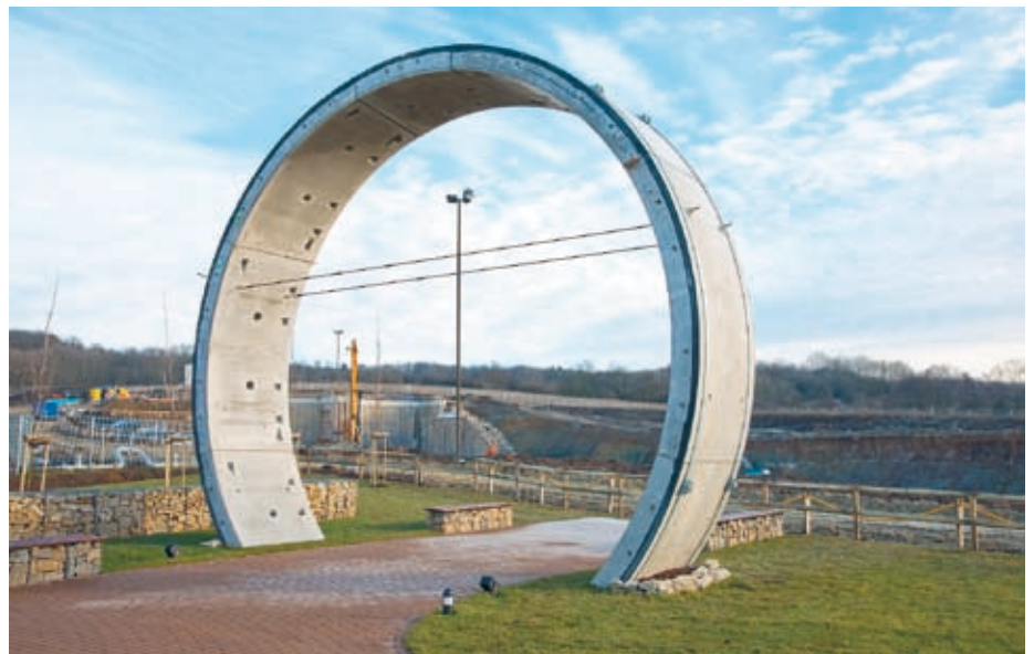
□ Jede der beiden Tunnelröhren wird aus insgesamt 3 400 solcher Tübbing-Ringe bestehen
